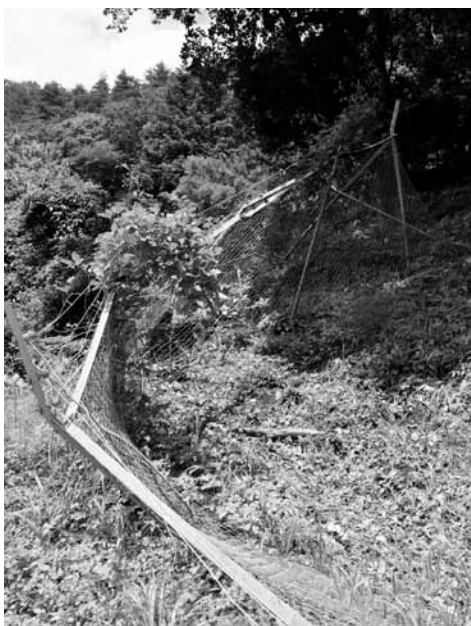
大雪により被害を受けた有害獣防護柵 (写真は和町田野地区)
