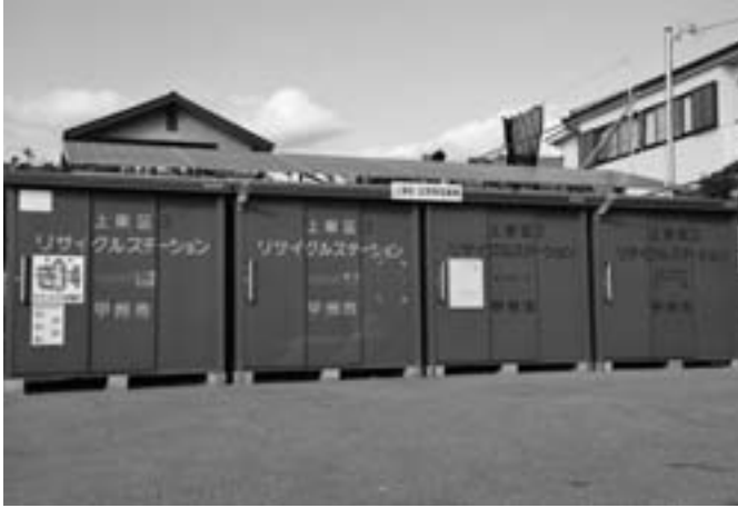
リサイクルステーションの運用により、衛生的で快適なまちづくり、資源の循環型社会が推進されている
