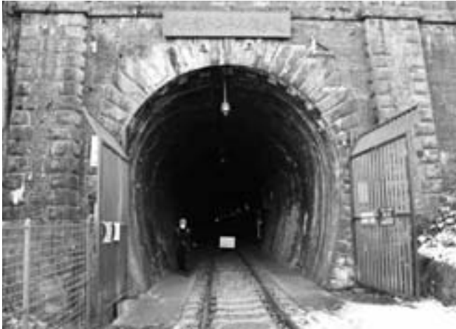
近代化産業遺産に認定されている大日影トンネル遊歩道
