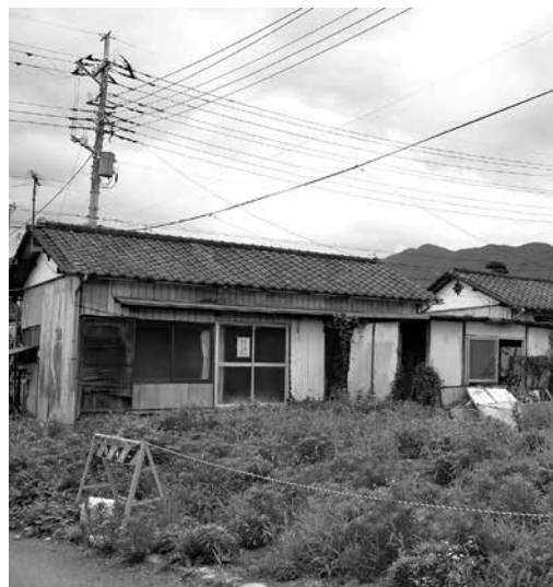
用途廃止となる熊野住宅。深刻な老朽化が見られる
