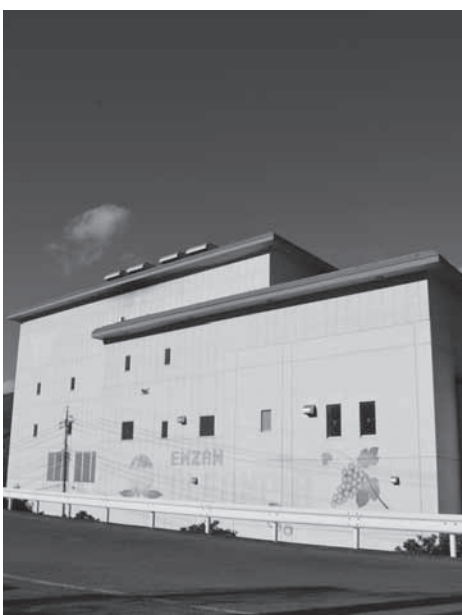
長年、撤去が求められているクリーンピアの工場棟
