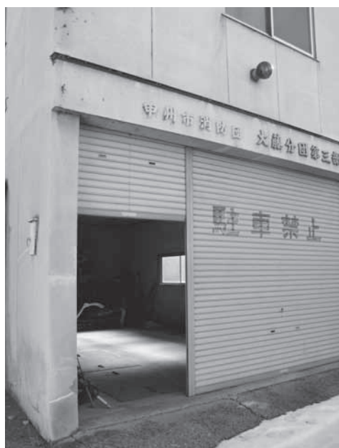
旧大藤分団第3部の詰所とともに撤去される、詰所地下の防火水槽
