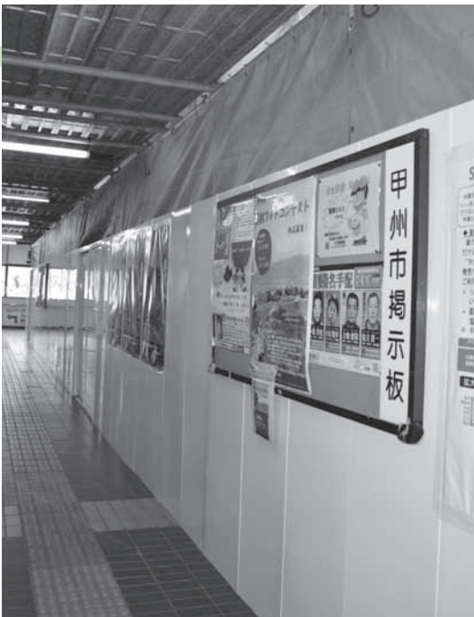
トランススイート四季島の運行に向け 工事中のJR塩山駅。構内には電子 広告板が設置される
