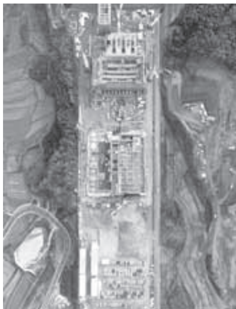
笛吹市内に建設中の新ごみ処理施設 (平成27年12月9日現在)
