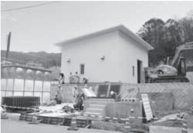
現在建設中の上萩原浄水場。上下小田原区への給水を担うこととなる
