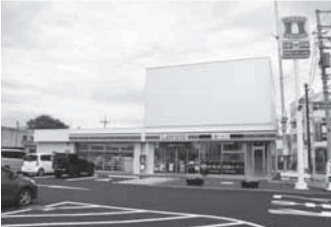
旧勝沼情報館を活用し、2月にオープンしたローソン甲州勝沼店
