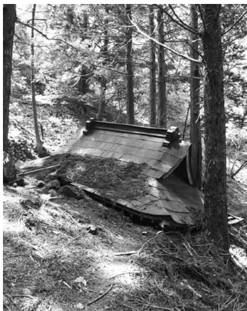
雪害により倒壊した大滝不動尊の金界坊堂
