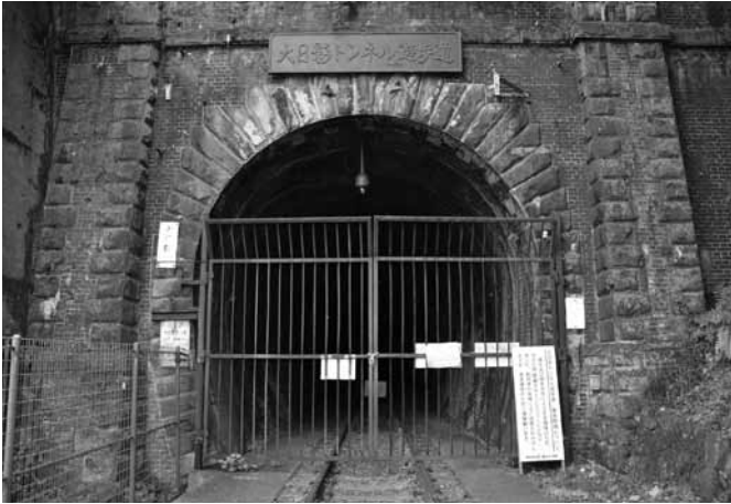
閉鎖中の大日影トンネル遊歩道
