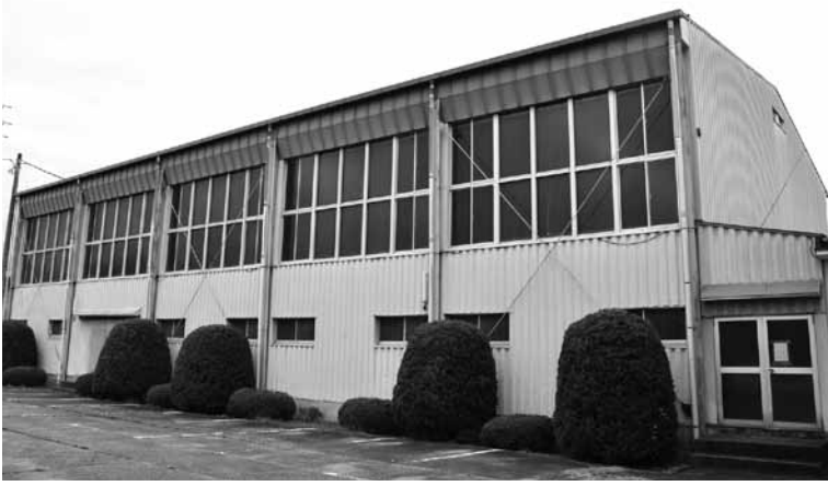
建築後40年以上が経過し、老朽化が進む勤労青少年ホームの体育館
