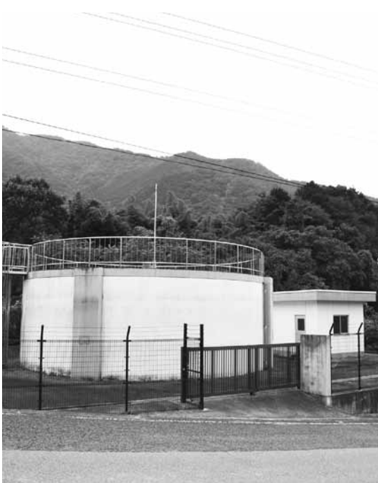
簡易水道事業会計では新たな簡易水道施設建設をめぐる討論が行われた（写真は中萩原の低区配水池）
