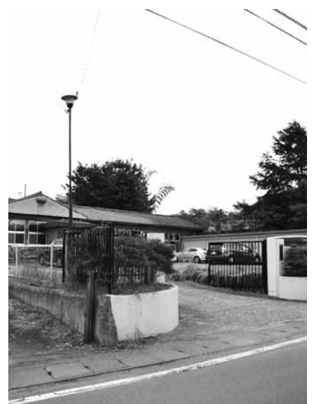
安全確保等のため、入り口が整備 される旧広瀬・琴川ダム事務所
