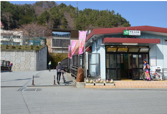
甲斐大和駅前の新初鹿野橋には雨よけシェルターが設置される
