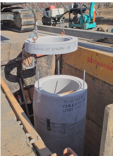
下水道マンホール設置工事の様子
