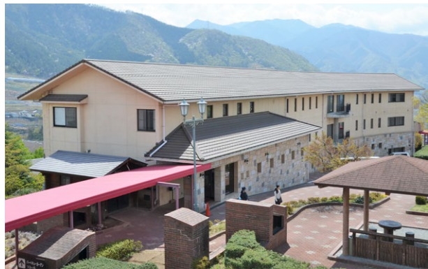
空調整備改修が完了予定の勝沼ぶどうの丘宿泊棟
