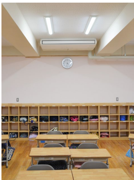
小中学校の各教室に設置されているエアコン。経費節減を図りながらも良好な学習環境を維持してほしい
