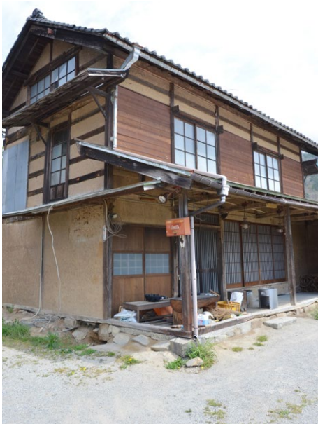
上条集落にある納屋が農泊施設として整備される
