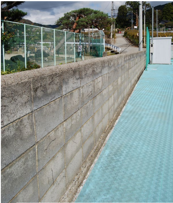
倒壊等を防ぐため、3つの小学校において改修工事が行われるブロック塀。安全確保に向けて万全な対応が求められる
