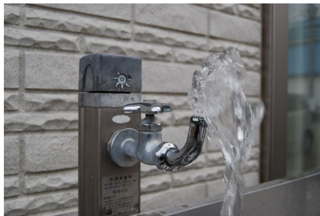
水道事業の統合や広域連携は県が主体になり関係市町村等と検討協議が行われている
