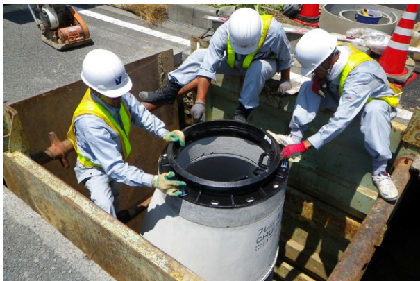
公共下水道への接続を促進して収入を上げていきたい下水道事業
