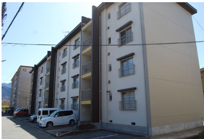
外壁改修等が行われた上塩後住宅。今後も市営住宅等の適正な維持管理が求められる
