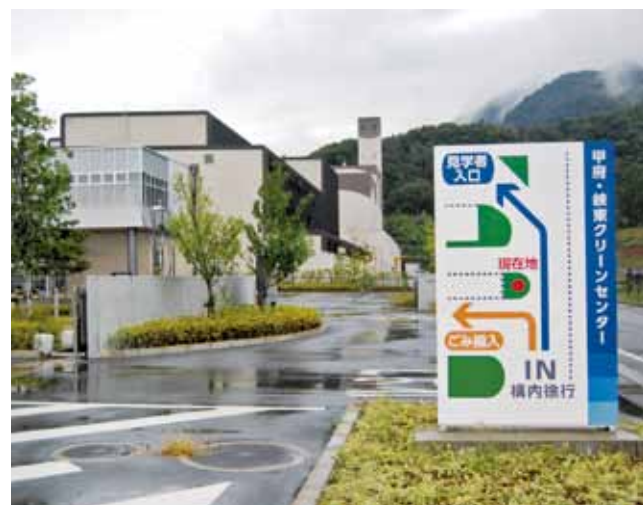
発電設備を備えた甲府・峡東クリーンセンター
