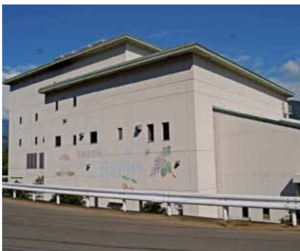
令和3年度に解体される環境センター。解体後の跡地利用が注目される
