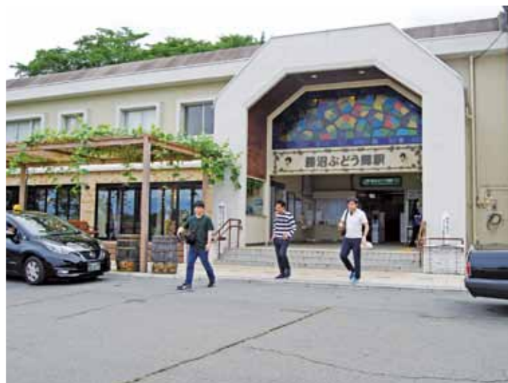
トイレや観光案内所などの感染症防止対策工事が進められる
