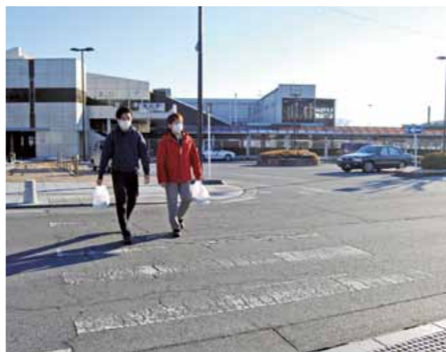
白線が消えかけている塩山駅北口前の横断歩道
