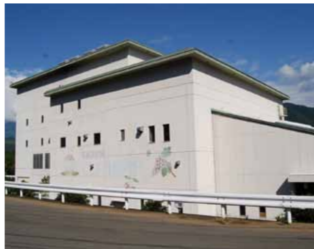
長年の懸案であったごみ処理場の解体は令和3年度に実施される
