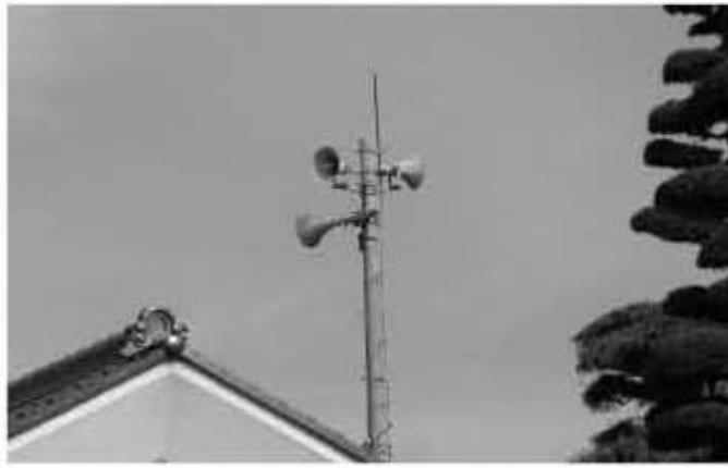
災害などに備え万全な整備が求められる防災無線の放送施設
