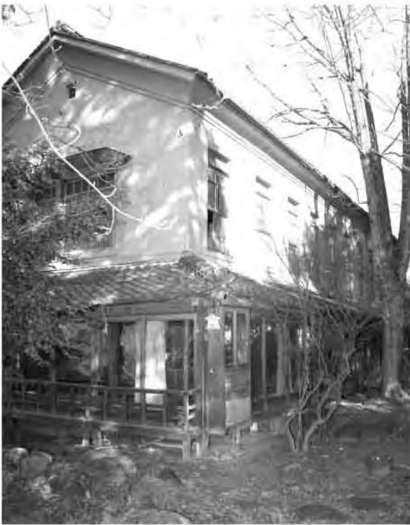
近代産業遺産整備事業により改修される宮光園母屋には、発見された関係資料の展示スペースなどが整備される
