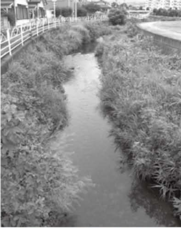
土砂のたい積により河床が上がっている塩川。大雨が降るとすぐに水位が上昇するため早急な対応が必要になる
