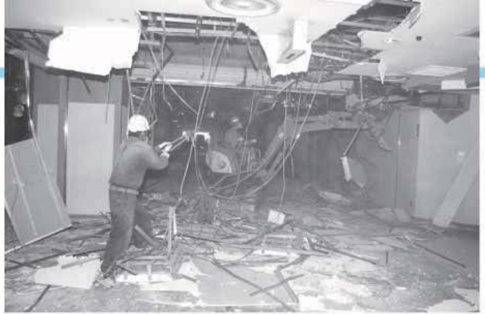
改修工事が始まった旧シルク。来年7月には市役所本庁舎として生まれ変わる予定である
