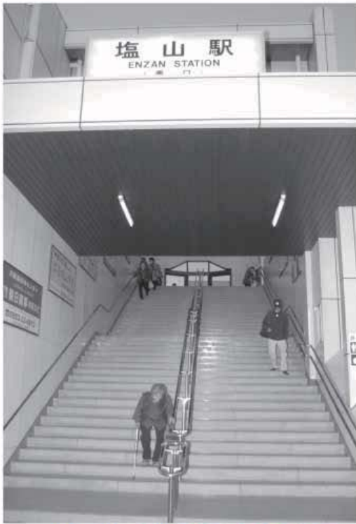
バリアフリーや利便性の向上などの観点から4基のエレベーターが設置される塩山駅
