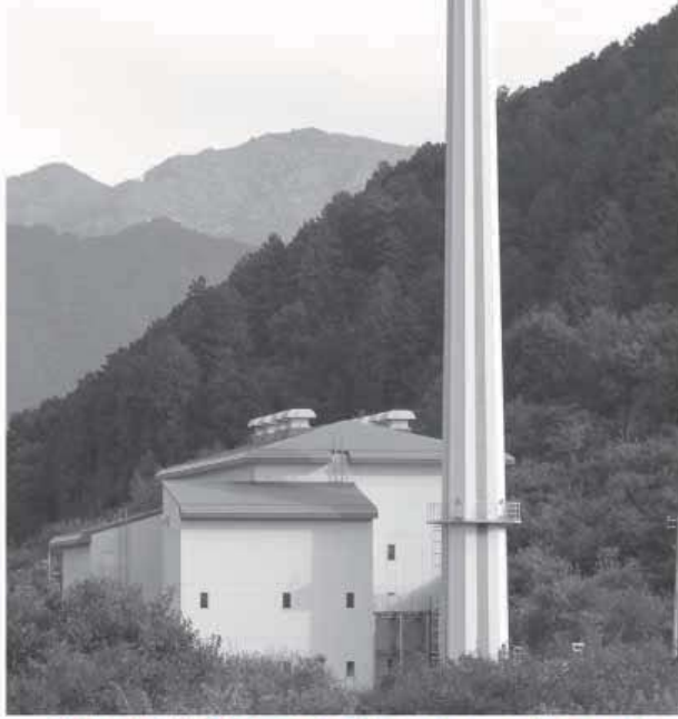
煙突の解体撤去が決まった環境センター。工事の際、周辺環境への配慮と安全管理の徹底が求められる
