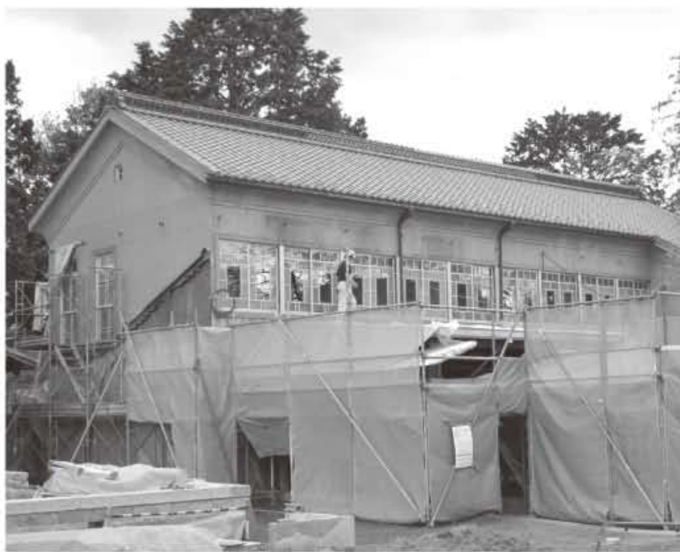
主屋の修復工事が進む宮光園。近代産業遺産としての価値を高め、観光振興につなげていきたい
