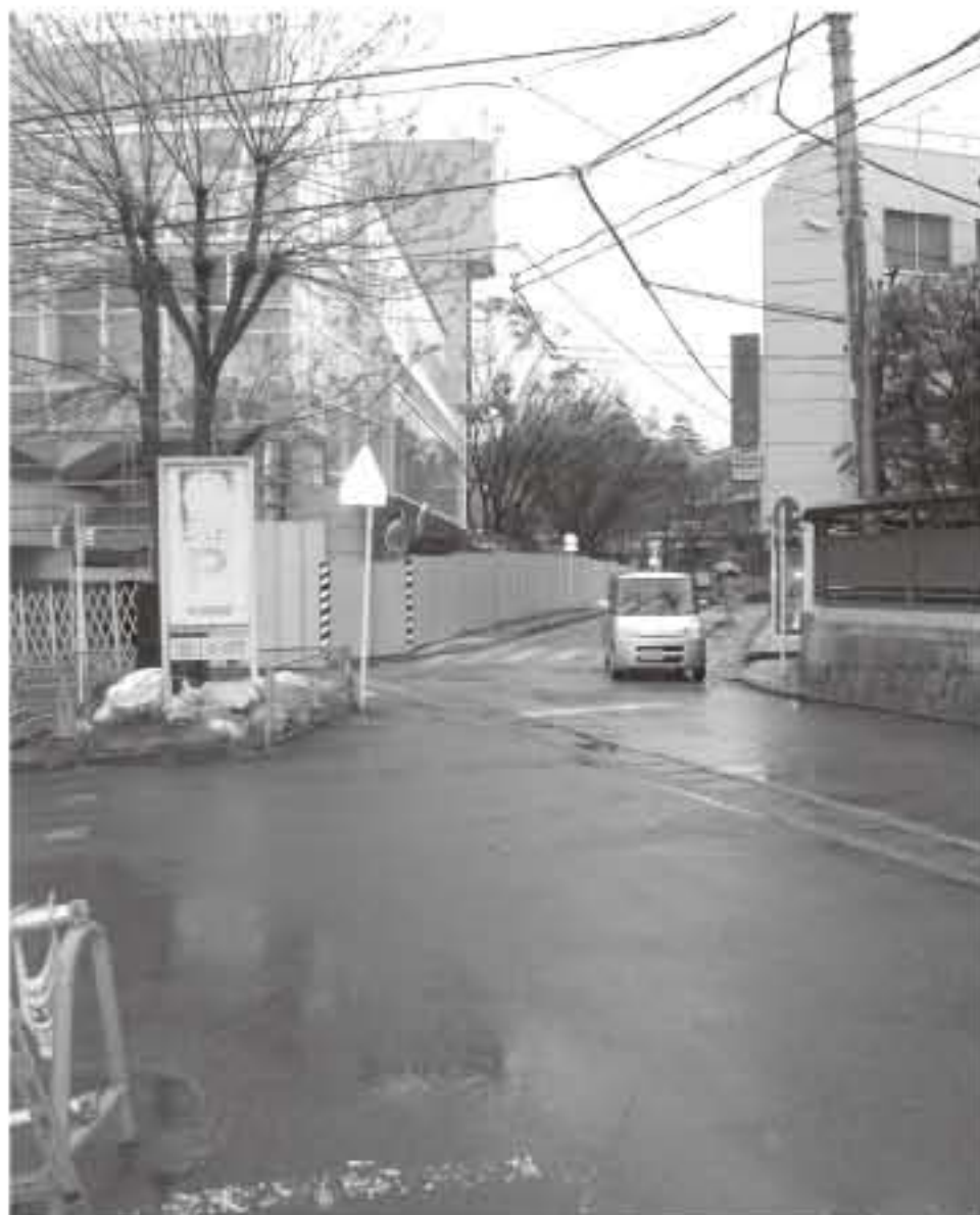
新本庁舎の整備に合わせて周辺道路や交差点の改良も行われる
