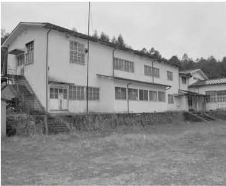
10年以上の休校と校舎の老朽化を理由に、2校の分校校舎が解体撤去される(写真は神金第二小学校落合分校校舎)
