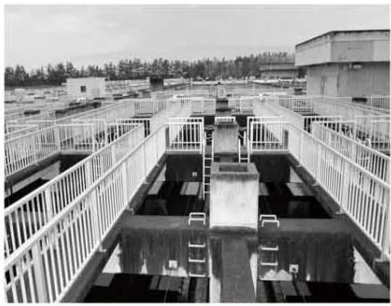
下水道に流される汚水の終末処理を行なう峡東浄化センター。峡東流域の下水道整備計画は平成25年に見直しが行なわれる
