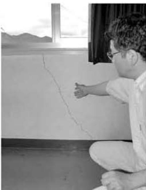
3月11日の地震で数多くの亀裂が発生した勝沼中学校校舎。早急に補修を行って安全を確保したい
