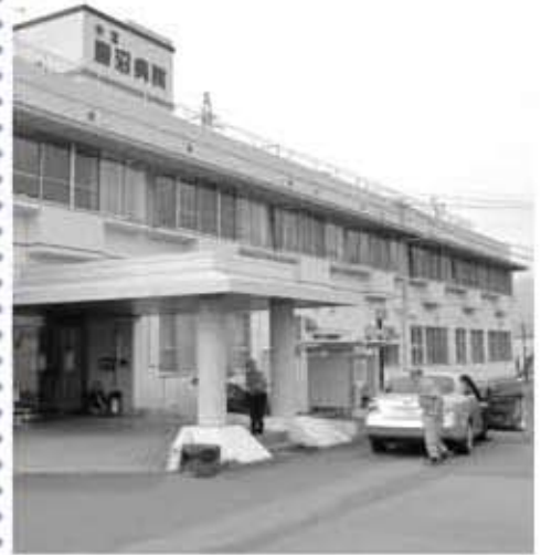
築27年となる勝沼病院のメイン病舎は、来年度に屋上防水工事などが実施される
