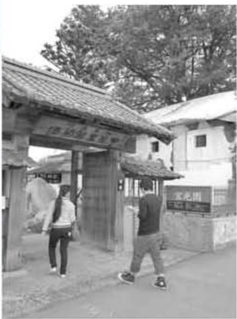
主屋の修復整備が終了した宮光園。2期工事では白蔵や離れ屋敷等の整備が計画されている
