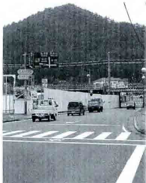
幅員改良工事が進む仲沢ガード。平成二十一年度の供用開始に向け工事が進んでいる。
