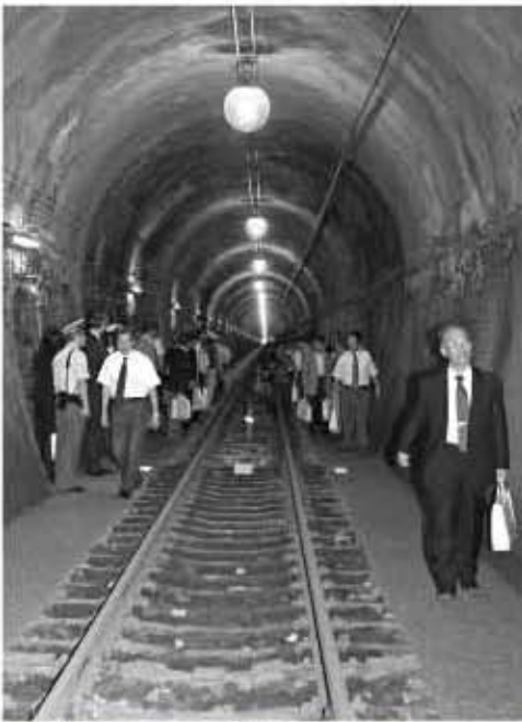
新たな観光施設として期待される大日影トンネル遊歩道。しっかりとした安全管理が望まれている。
