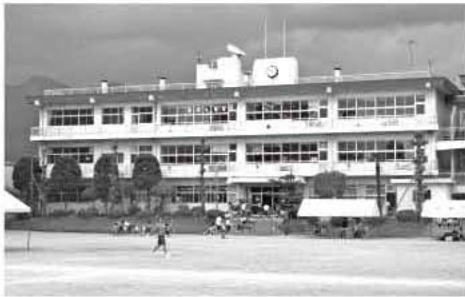
耐震診断が終了した松里中学校。平成20年度に耐震補強工事が行われる予定である。
