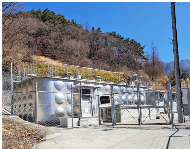
令和7年度から下小田原への配管工事が始まり、送水が開始される上小田原配水池
