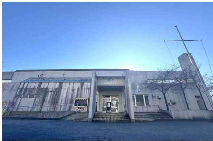
屋内温水プールとトレーニングルームを備えた塩山B & G海洋センター
