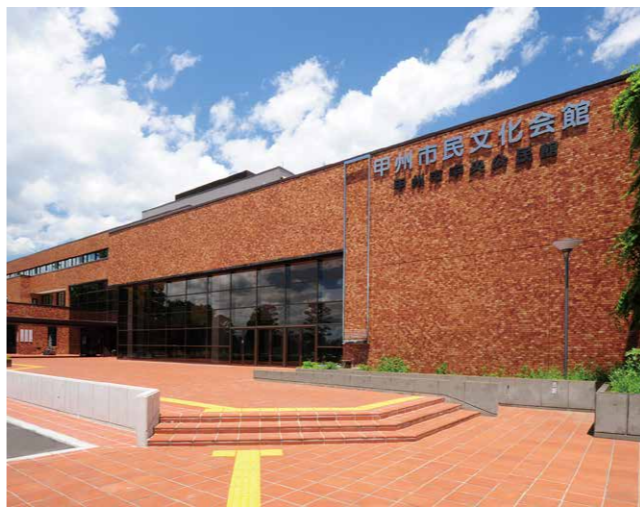
設置されて太陽光パネルにより7カ月で前年対比6万8000円削減
