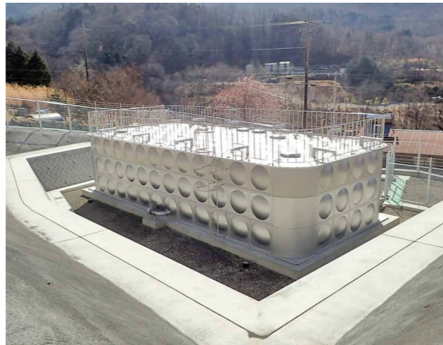
令和3年3月築造の上小田原配水池
