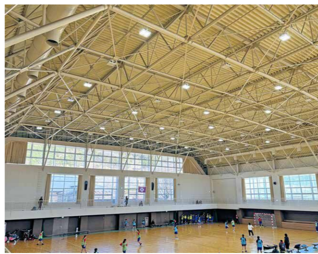
空調設備整備の設計を行う塩山体育館
