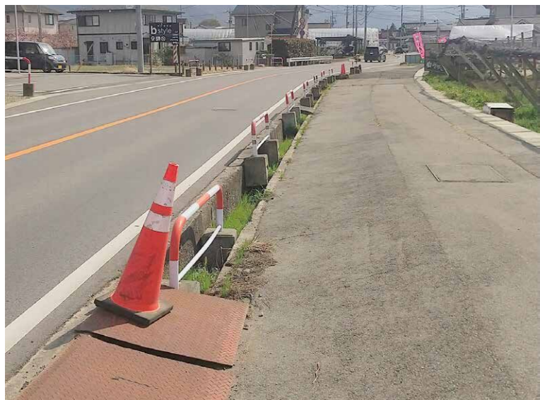
電線共同溝工事に伴う配水管移設が予定される国道411号
