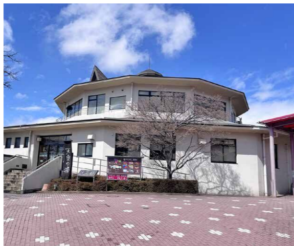
クラウドファンディングを活用し、大規模改修工事予定の勝沼ぶどうの丘ふれあい交流館（天空の湯）
