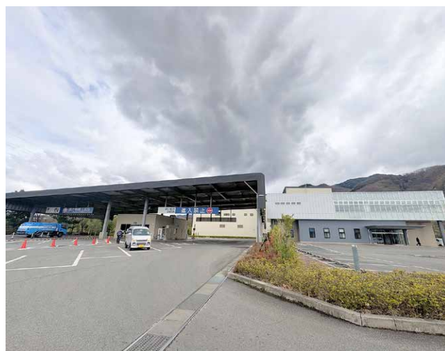
粗大ごみを直接持ち込む場所の一つである 甲府・峡東クリーンセンター
