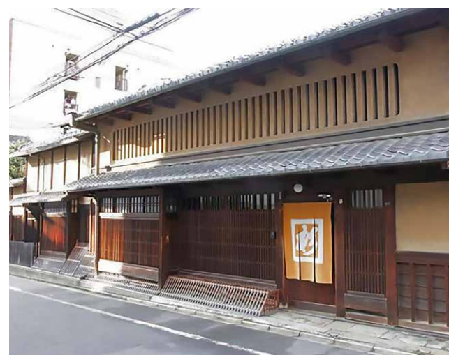
杉本家住宅（京都、重要文化財） 民間主導で寄附を集め、大屋根葺き替え工事を行った
