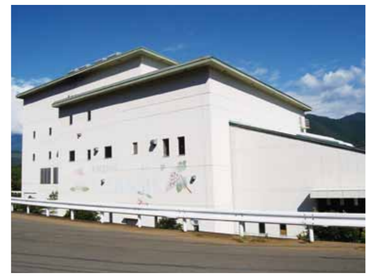
解体される環境センターごみ処理施設
