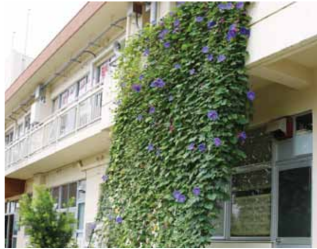
校舎の南面に設置された緑のカーテン
