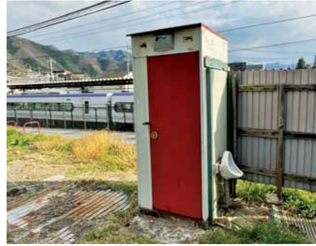
管理面の改善が求められる甘草屋敷駐車場のトイレ
