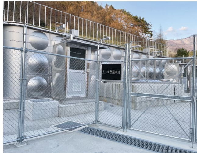
完成した上小田原配水池
