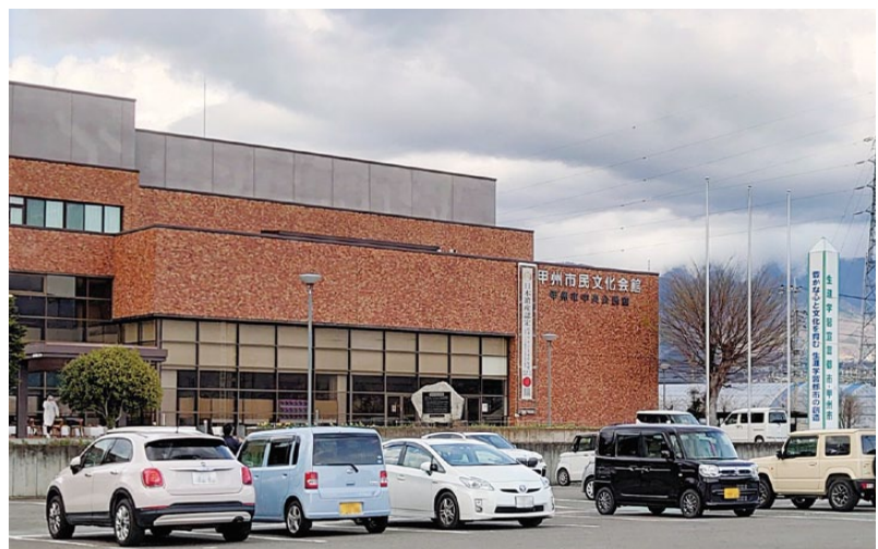
不燃ごみと可燃ごみが同時に収集できるようになる市民文化会館
