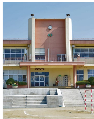
設計費が計上され、大規模改造工事が予定される塩山中学校
