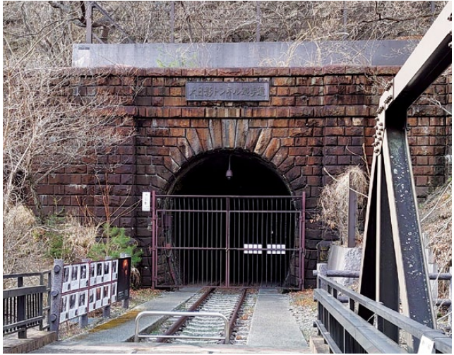
利用再開による経済効果が期待される「大日影トンネル遊歩道」
