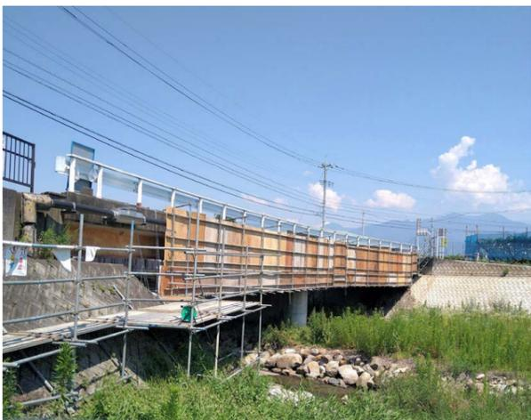
橋梁長寿命化修繕計画に則り改修工事が行われている穴田橋
