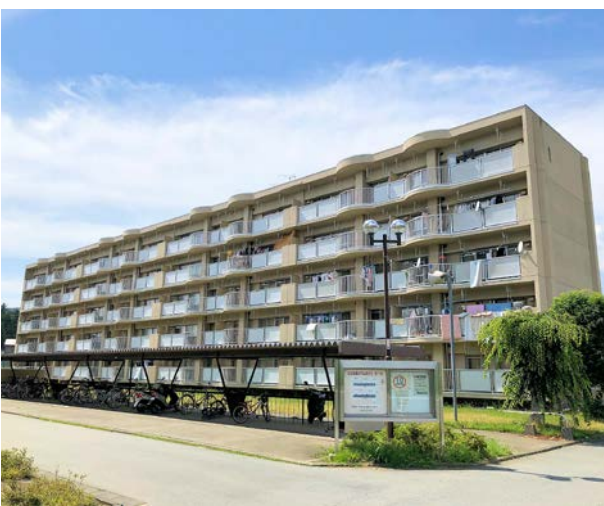
令和5年4月から家賃が減額となる市営定住促進住宅 (写真は松里住宅)
