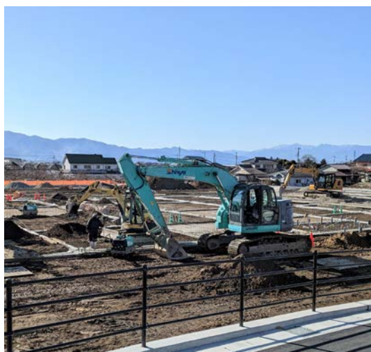
建設中のJA新塩山共選所
