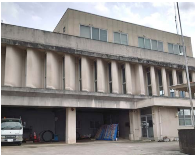
令和5年度に解体が予定されている 塩山郵便局南側の旧市役所別館
