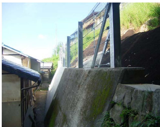
塩山の番屋地区にある県工事箇所
