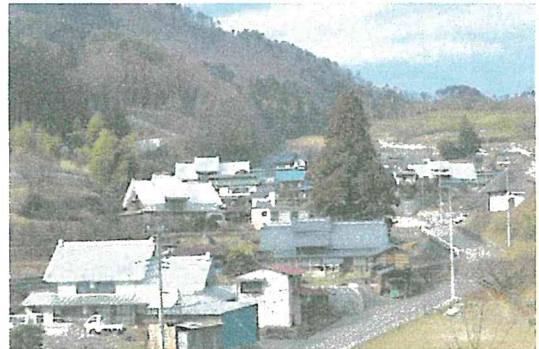
茅葺きの甲州民家が残る上条集落
