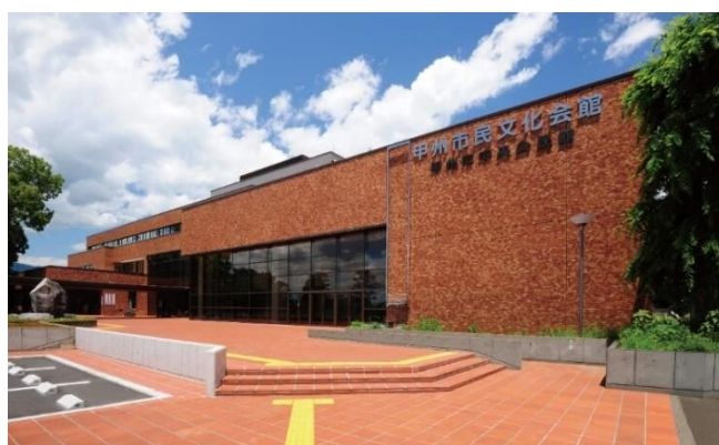
図3.7 甲州市中央公民館(甲州市民文化会館)
