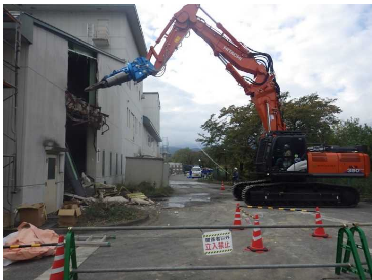
⑤ 工場棟 東側プラットホーム解体状況
