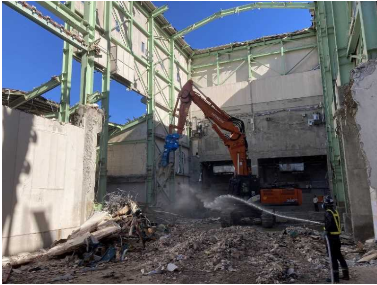
⑪ 工場棟 建屋内部解体状況（西側）
