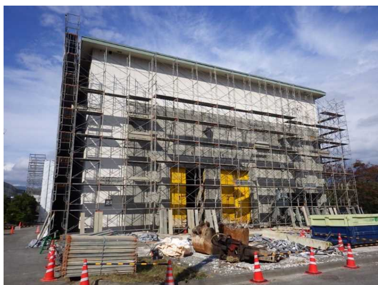
⑦ 工場棟 養生足場組立状況（東側）
