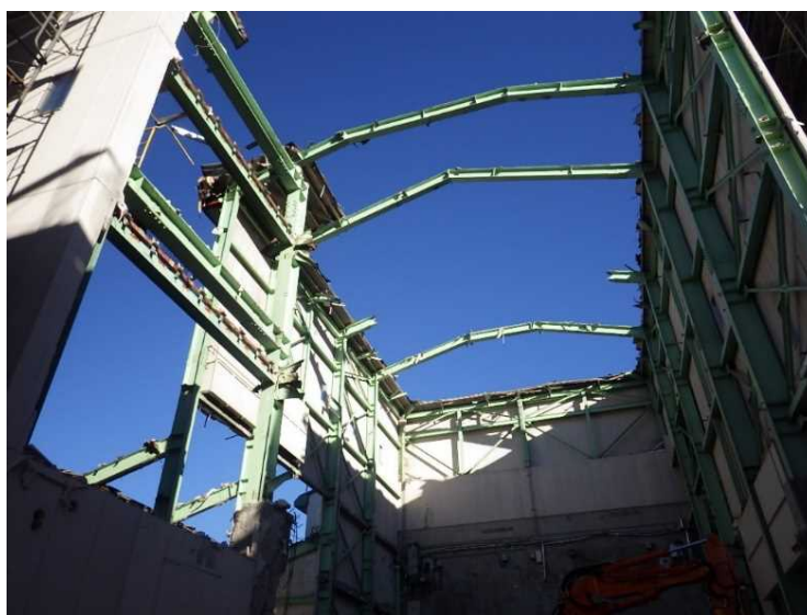
⑩ 工場棟 建屋屋根解体状況（西側）
