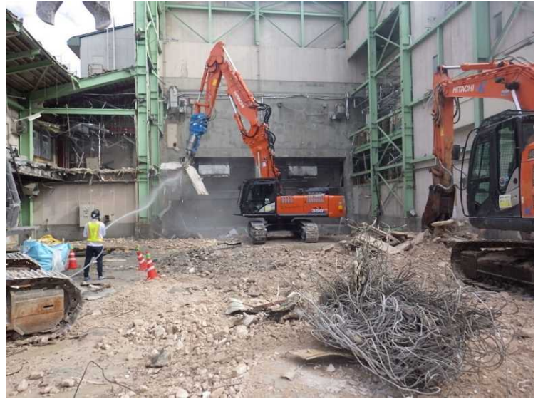
⑫ 工場棟 建屋内部解体状況（西側）
