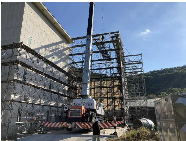
③ 工場棟 管理区域解体ヤード撤去状況
