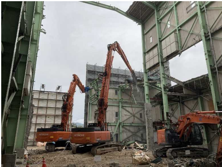
⑬ 工場棟 建屋外壁解体状況（西側）
