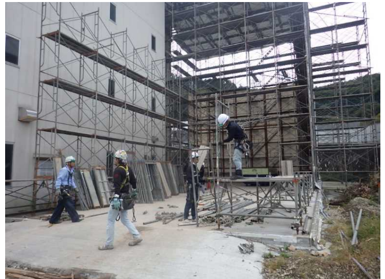
④ 工場棟 管理区域解体ヤード撤去状況
