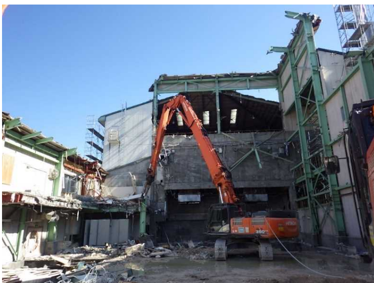
⑮ 工場棟 建屋屋根大梁解体状況（西側）
