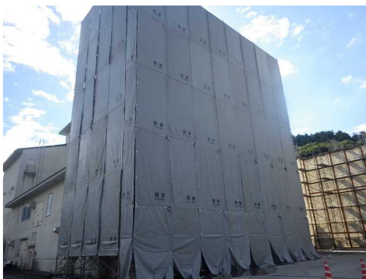
⑧ 工場棟 養生足場組立状況（西側）
