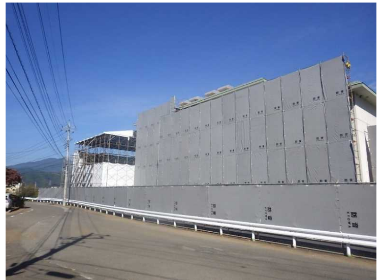
② 仮囲い及び工場棟 防音シート設置状況
