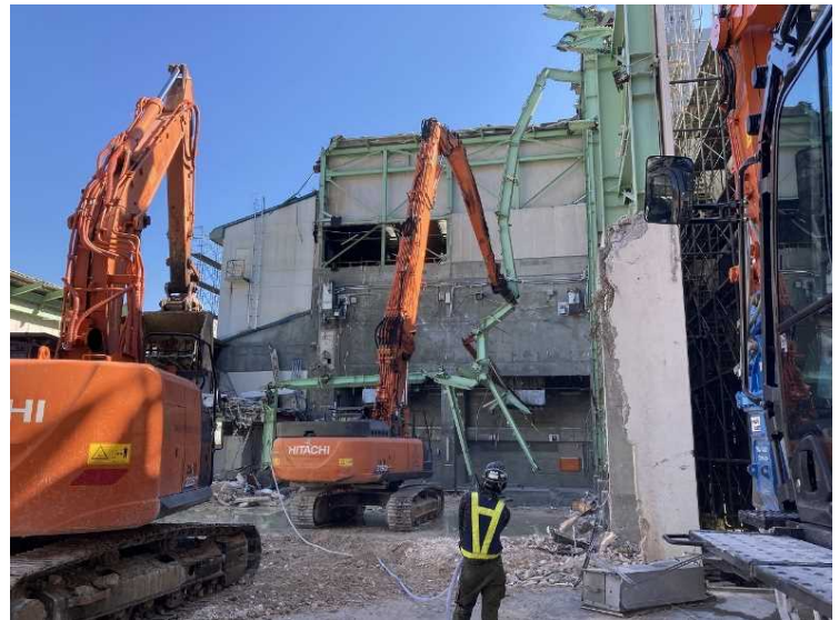
⑭ 工場棟 建屋屋根大梁解体状況（西側）
