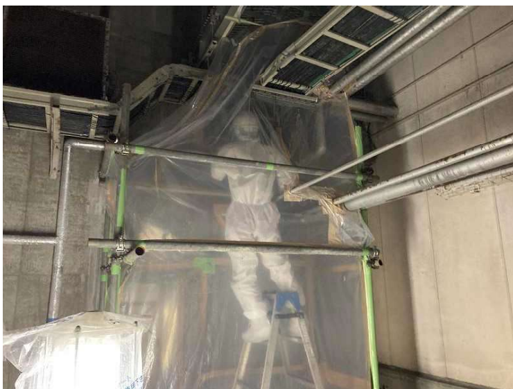
⑨ 工場棟 石綿含有材撤去状況
