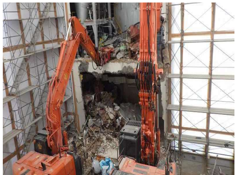
⑯ 工場棟 機械設備解体状況
