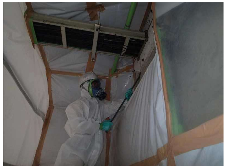
⑩ 工場棟 石綿含有材撤去状況
