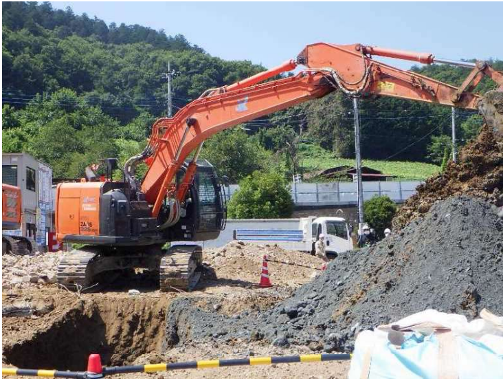
⑤ 管理棟 地下水位 試掘調査
