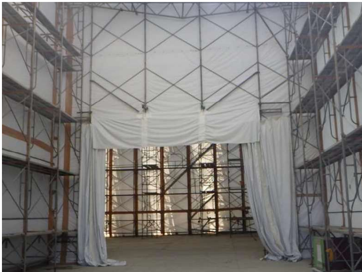
⑬ 工場棟 解体ヤード 前室養生検査
