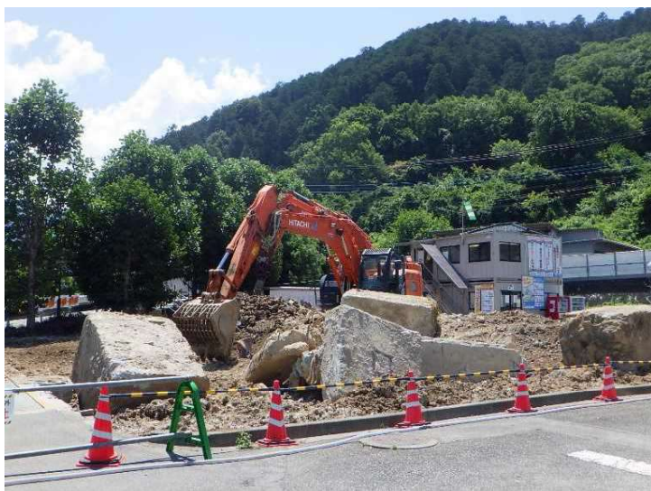
③ 管理棟 基礎コンクリート解体状況
