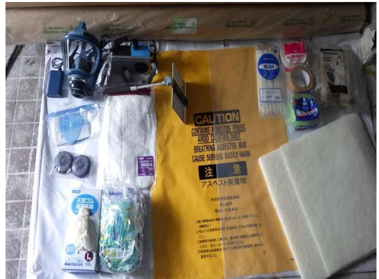
⑧ 工場棟 石綿含有材撤去前 保護具検査
