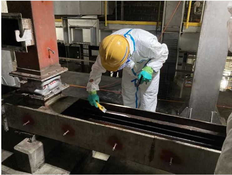
⑪ 工場棟 汚染物除染完了 確認状況
