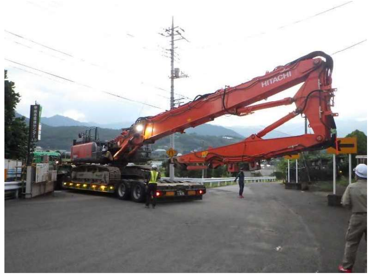
⑫ 工場棟 解体用特殊車両搬入状況
