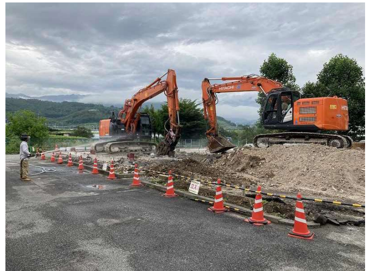
② 管理棟 基礎コンクリート解体状況
