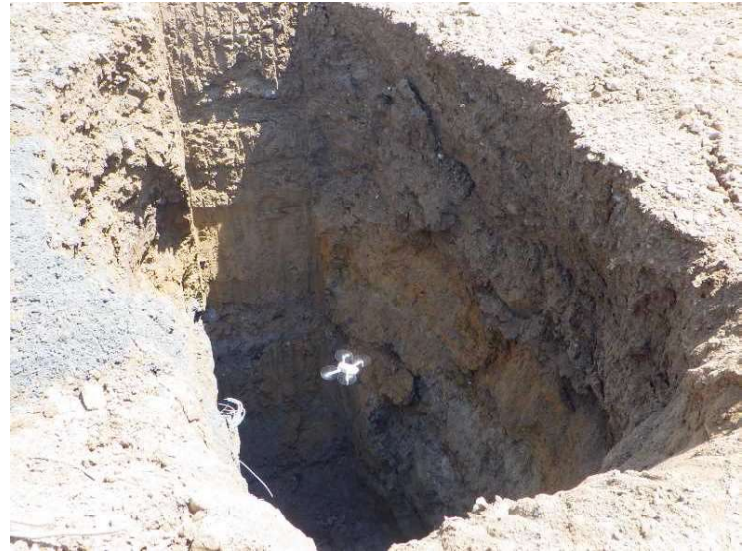
⑥ 管理棟 地下水位 試掘調査・撮影
