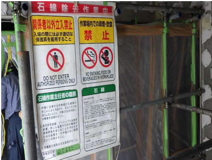
⑦ 工場棟 石綿含有材撤去前 養生検査
