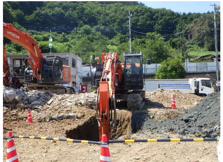
④ 管理棟 地下水位 試掘調査
