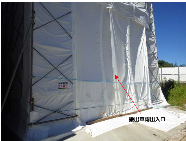
③ 工場棟 解体ヤード搬出口密閉状況
