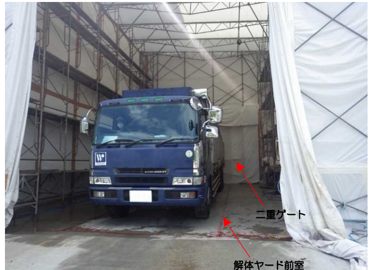
④ 工場棟 解体ヤード前室搬出車両状況
