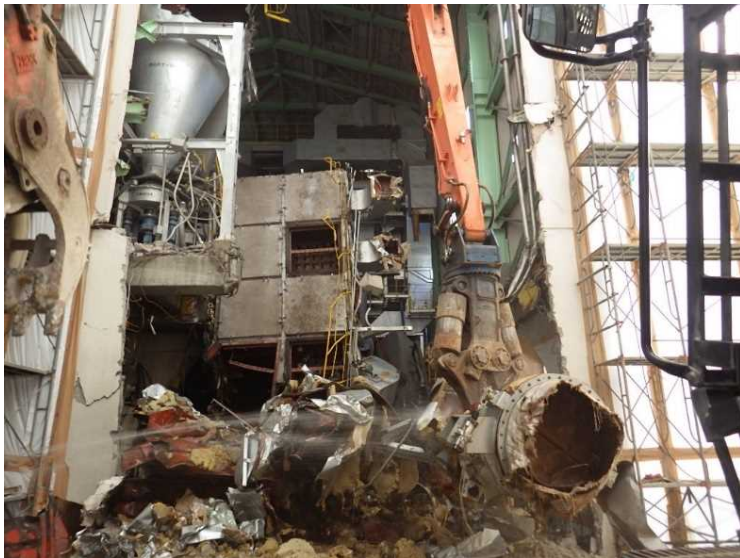
⑦ 工場棟 設備機器解体状況
