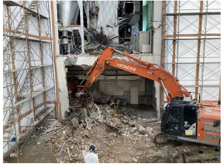
⑥ 工場棟 設備機器解体状況
