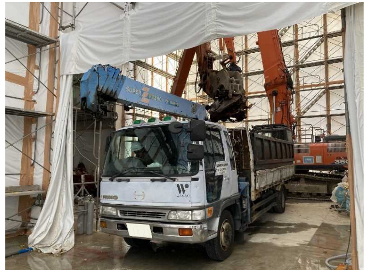
⑭ 工場棟 解体材積込・搬出状況
