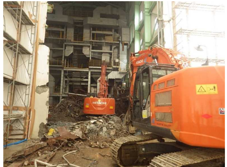
⑧ 工場棟 設備機器解体状況
