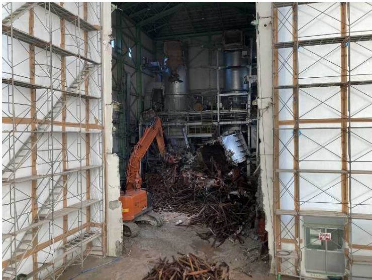
⑬ 工場棟 設備機器解体状況
