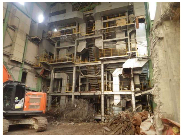
⑩ 工場棟 設備機器解体状況
