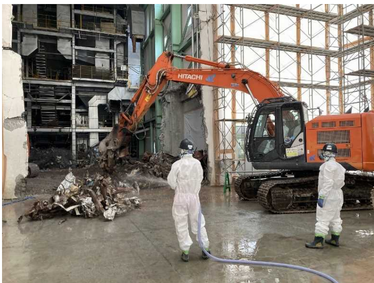
⑨ 工場棟 設備機器解体状況
