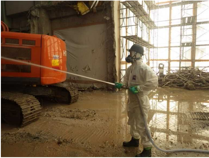
⑤ 工場棟 保護具着用・散水状況（レベル2）
