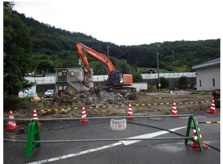
② 管理棟 基礎コンクリート小割状況
