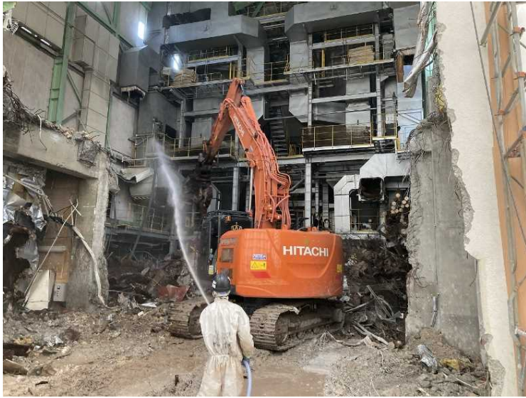
⑪ 工場棟 設備機器解体状況
