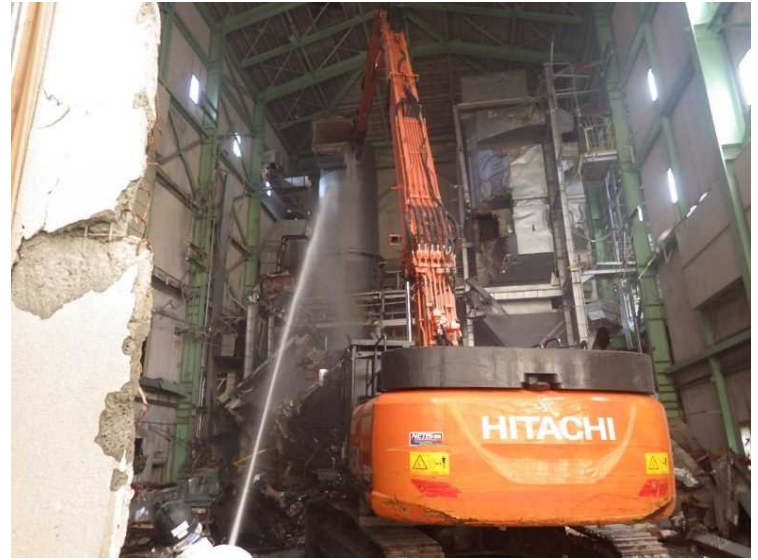
⑫ 工場棟 設備機器解体状況
