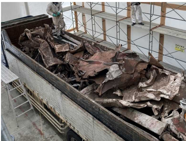
⑮ 工場棟 解体材積込・搬出状況
