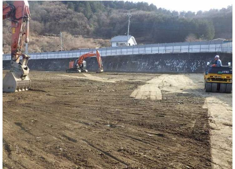
④ 工場棟 埋戻し・転圧状況
