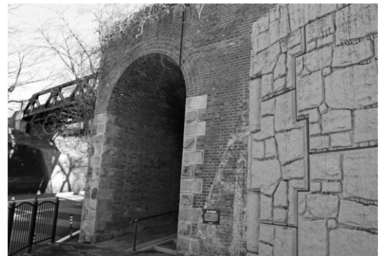
図3 菱山道路隧道
