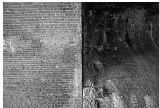
図4 菱山道路隧道におけるレンガ積
