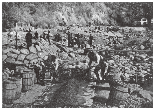
図 38 日川水制の工事写真
