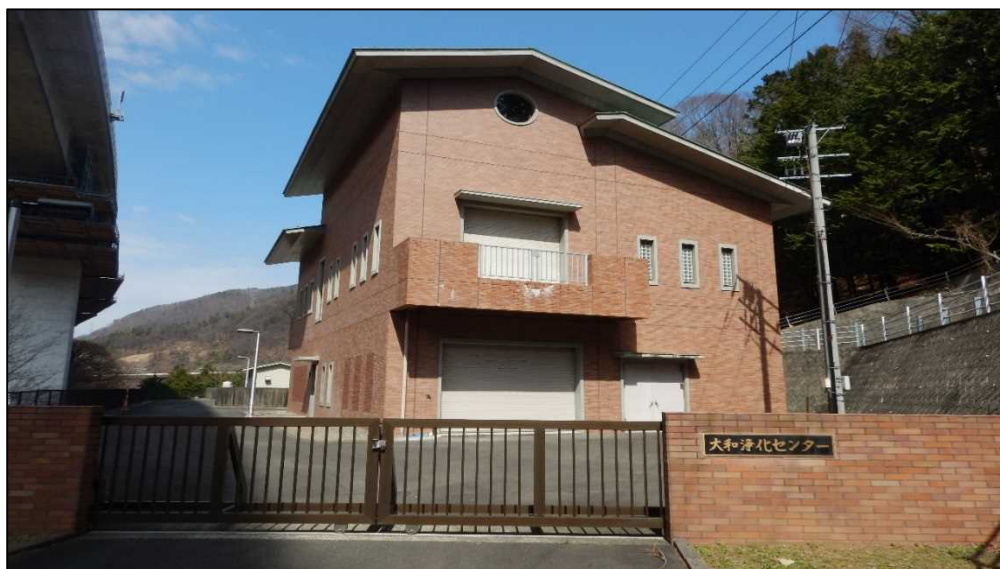
大和浄化センター（管理汚泥棟）
