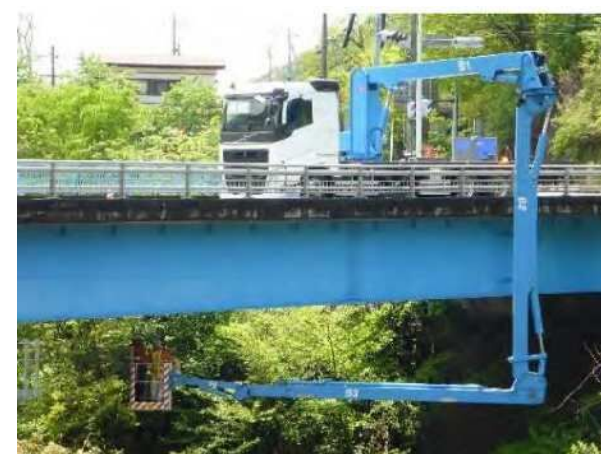
写真 従来技術の点検手法（左：橋梁点検車、右：ロープアクセス）
