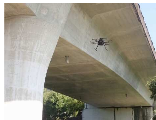
写真 新技術の点検手法（左：ドローン、右：点検支援ロボット）
