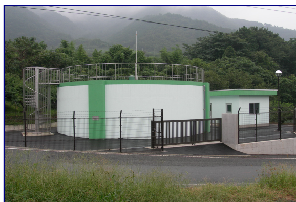
塩山 東部低区配水池
