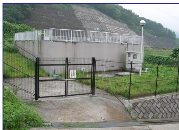
勝沼 岩崎配水池
