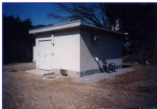
大和 中部配水場
