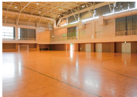
空調設備の導入が進められる塩山体育館
