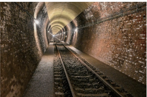
㉕大日影トンネル遊歩道 リニューアルオープン
