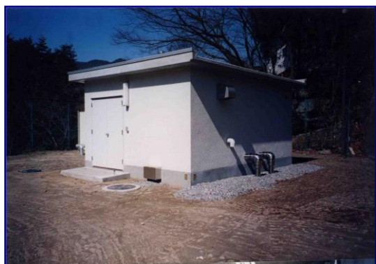
大和 中部配水場
