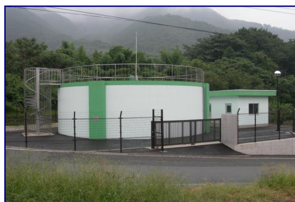
塩山 東部低区配水池
