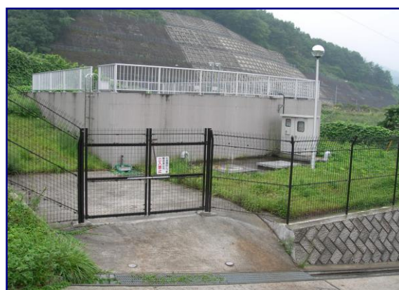
勝沼 岩崎配水池
