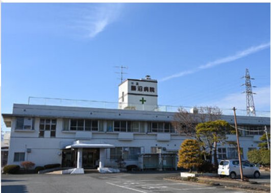
空調設備の改修工事が予定されている勝沼病院
